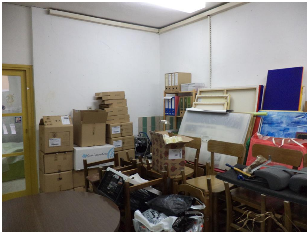
4. Slika 4. Ploča sa osiguračima u prostoru
